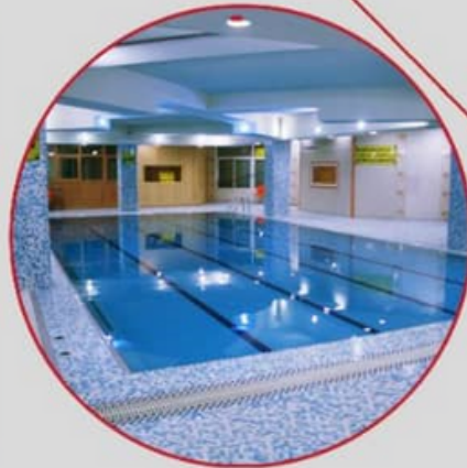
◀ اجرای دیواره زیرزمین، سونا و جکوزی و استخر
