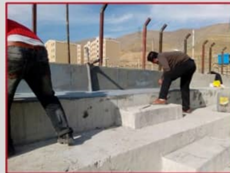
▲ مقایسه عایقکاری ایزوگام و پنتون در کرسی چینی زیر دیوارها ▲
