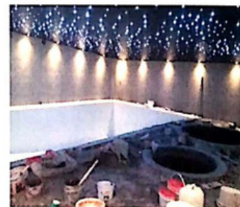
اجرای دیواره زیرزمین، سونا و جکوزی و استخر
