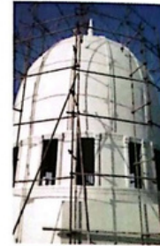
اجرای عایق کاری گنبد مسجد و مکان قشم
