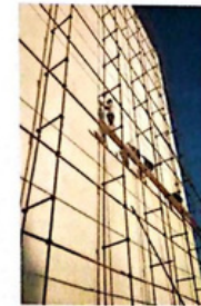
اجرای عایق UV دار سفید بر روی دیواره ها
